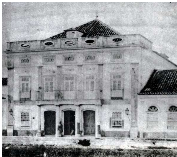
3 – Fotografia da fachada do Teatro Sete de Abril, de Pelotas, em 1875. Teatro Sete de Abril. Pelotas: Fundapel, p. 31.
