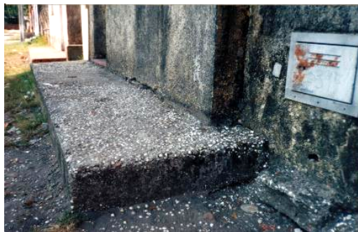
FIGURA 02: Passeio e alvenaria construídos com a concha do chumbinho substituindo a brita. (Foto de Lauro Souza, 2001).
