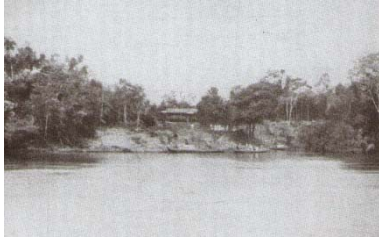
Figura 2: Casa ao longo do rio Tocantins
