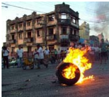
Figura 1: Reivindicação de comerciantes pelo bloqueio da Rua Maciel Pinheiro, cuja interdição provocou diminuição de seu comércio local. Ao fundo, a edificação com riscos de desabamento que causou a intervenção na rua. Foto: Jornal O Norte On Line, Novembro 2004.
