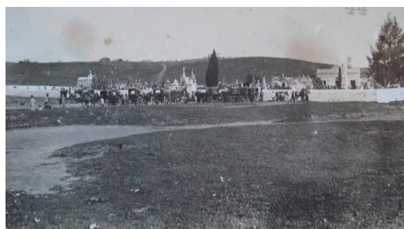
Figura 1: Visão frontal do conjunto do Cemitério da Santa Casa de Caridade de Bagé/RS Acervo: Fototeca Túlio Lopes, do Museu D. Diogo de Souza
