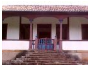
Figura 3: detalhes da varanda e do telhado
