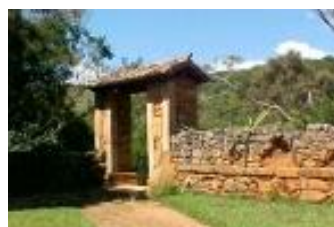
Figura 5: ruínas da senzala
