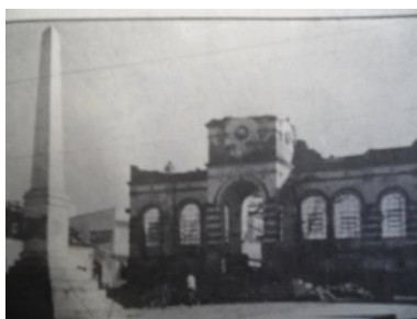
Imagem 05: Demolição do Mercado 1970
