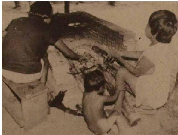
Figura 3. “Aspecto da cozinha da Casa do Índio”. Amazonas em Tempo , Manaus, 20/06/1993.
