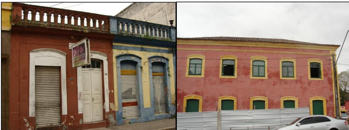
Figura 1. À esquerda a construção do período colonial em que foi adicionada a platibanda e à direita a casa Dacheux, durante as obras de restauração.
