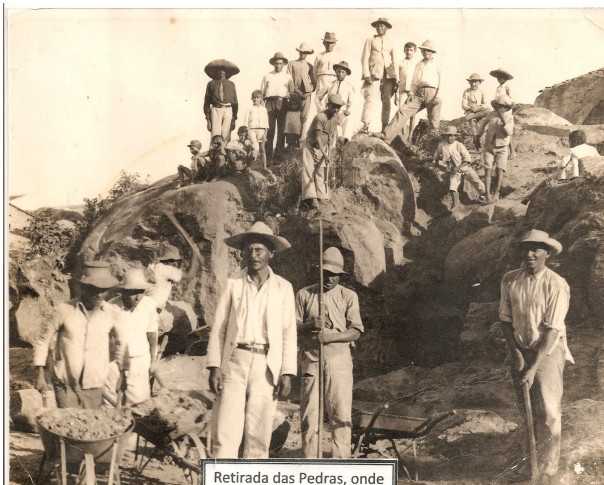
Retirada das Pedras, onde
