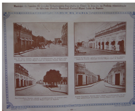
Ilustração 1 – As ruas de Juazeiro: pavimentação e fachadas imponentes indicavam uma urbanização sólida.
