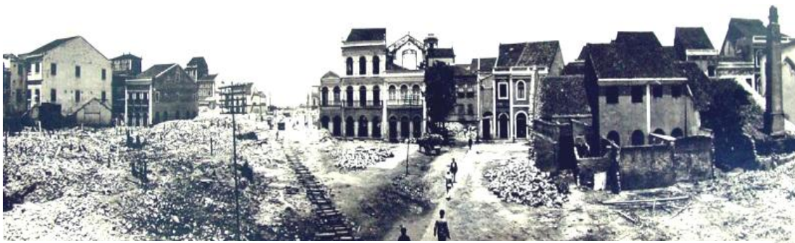
Demolições no Bairro do Recife - Travessa do Corpo Santo, 1913. Acervo: Fundaj
