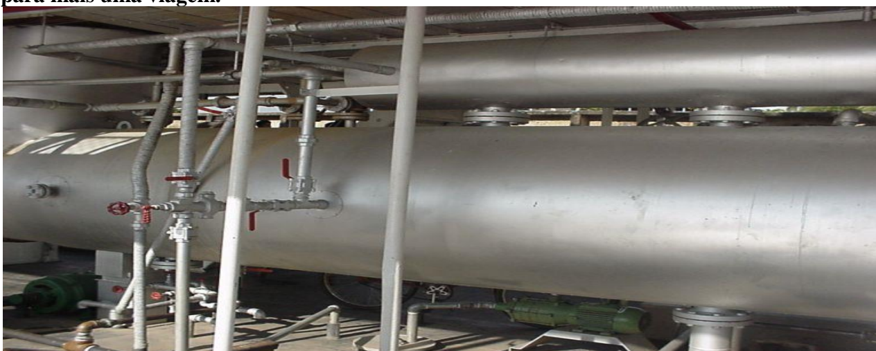
Foto 04 - A nova caldeira do vapor Benjamin Guimarães, esperando ser aquecida para mais uma viagem.
