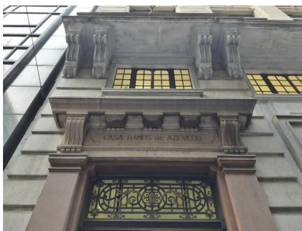
Fig. 2. Fachada do Edifício “Casa Ramos de Azevedo” situado à Rua Boa Vista, 138. Fonte: Carlos Moura, 2018.
