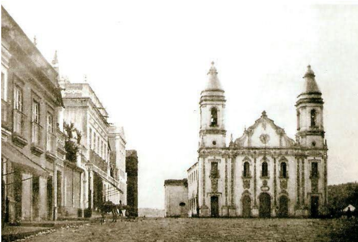
Figura 01: Igreja de Nossa Senhora da Conceição, Água Branca, AL
