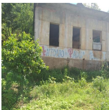
Fachada da antiga Água Farol, 2019. Fonte: Própria.
