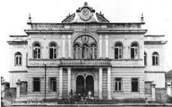
Fotografia 1 – Fachada Teatro Recreio
