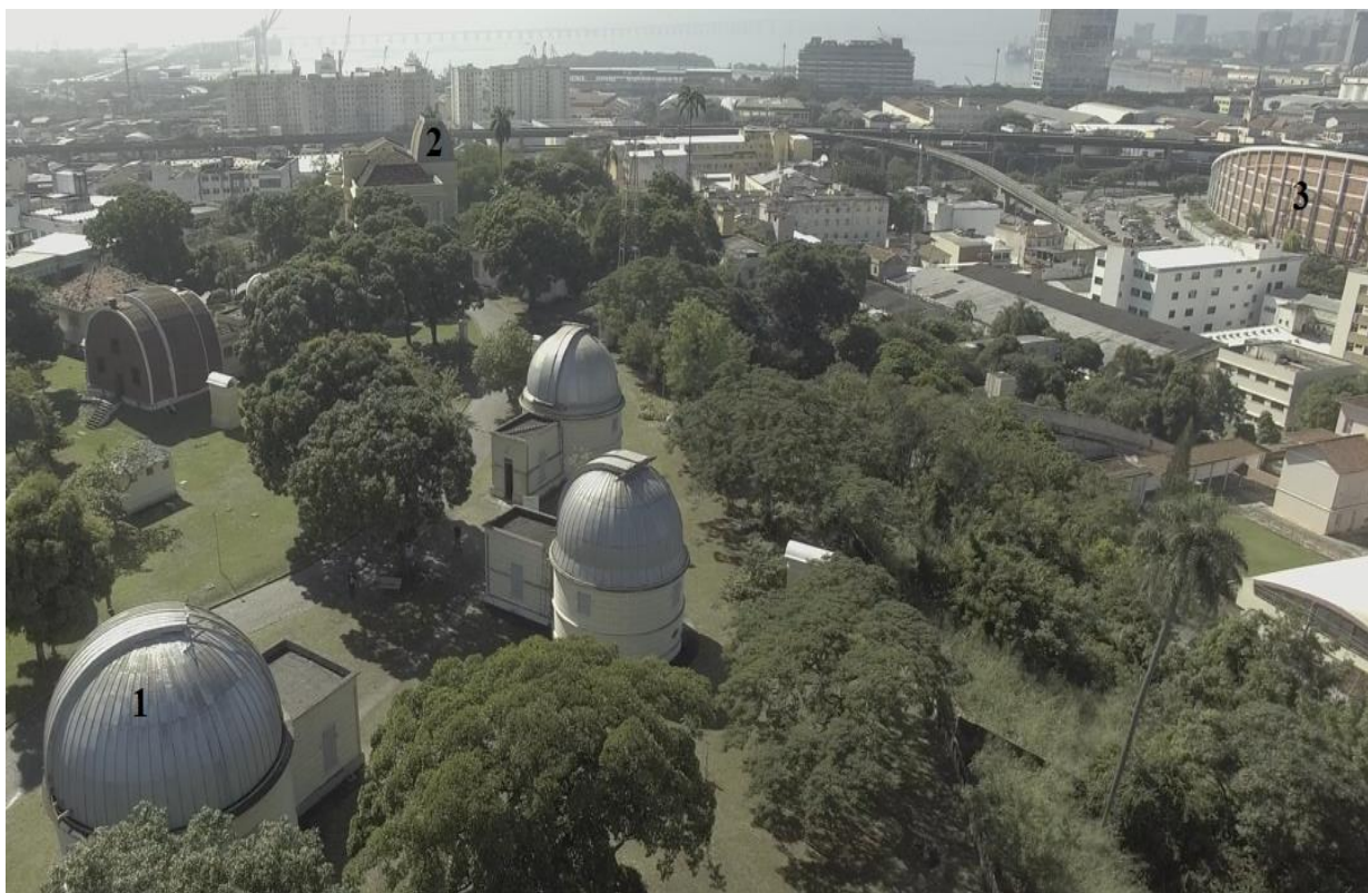
Figura 5 - Acervo Vozes da Ciência no Brasil – Fotografia de Drone (1) Cúpulas de observação astronômica; (2) edifício sede; (3) antigo Pavilhão da Exposição Internacional de Indústria e Comércio.
