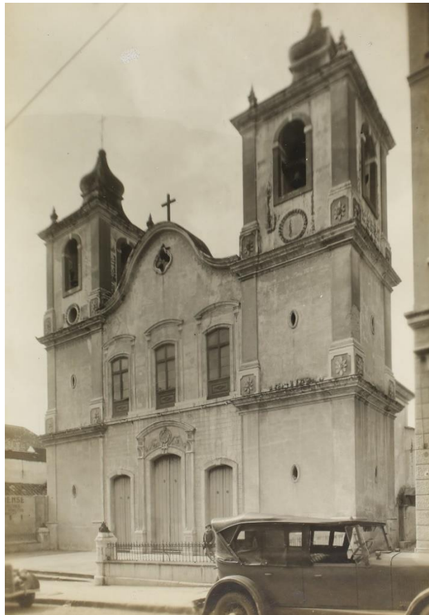
Imagem 1– Foto da fachada da Igreja de Nossa Senhora do Rosário, em Porto Alegre (RS)
