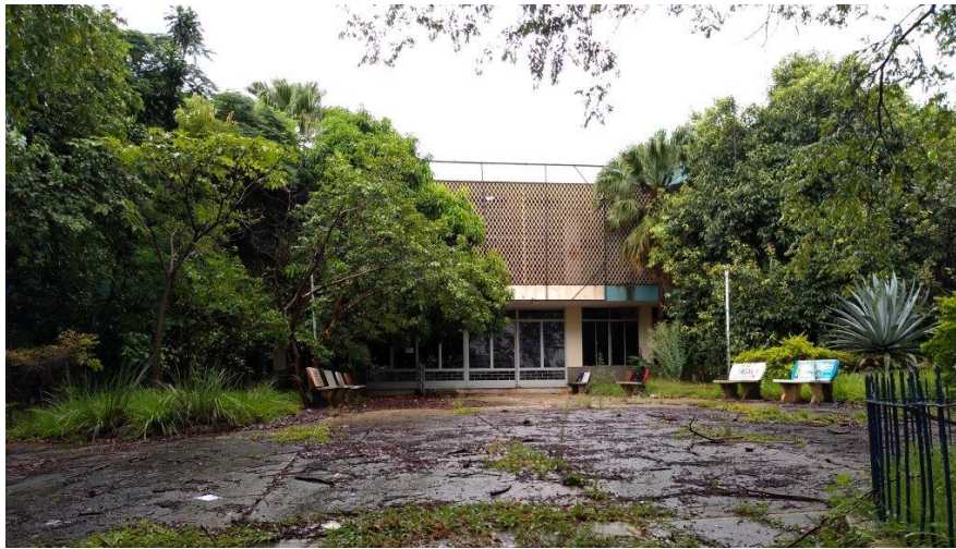
Figura 2 - Detalhes de Cobogós e vidros na entrada do prédio 2
