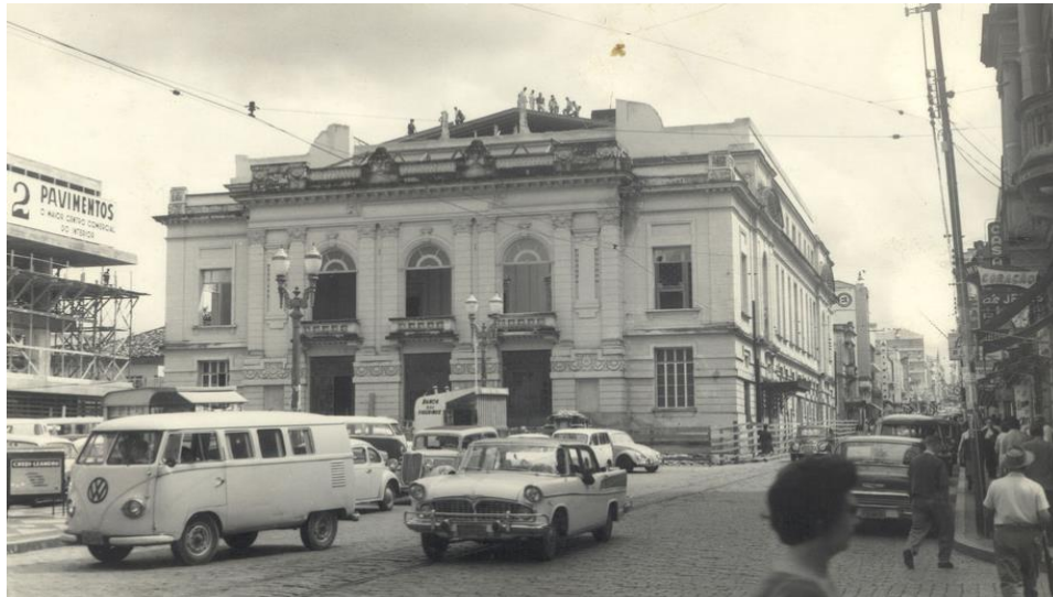
Início da demolição do Teatro Municipal, 1965. Conjunto APS, CMU
