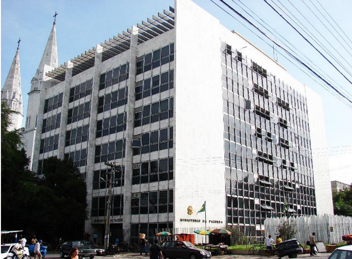
Figura 01: O prédio do Ministério da Fazenda em Teresina, localizado na Praça Rio Branco, ao lado da Igreja de Nossa Senhora do Amparo, c. anos 2000.
