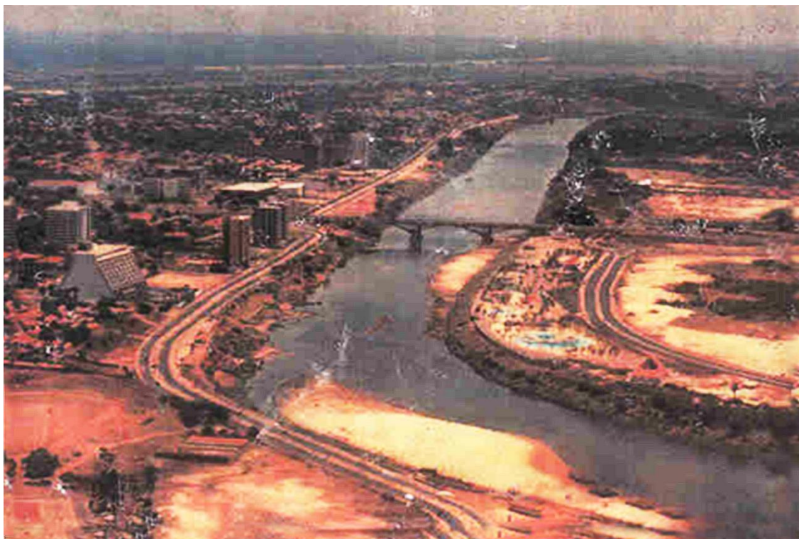
Figura 02: Vista panorâmica dos primeiros núcleos de concentração de edifícios residenciais na cidade de Teresina, na margem esquerda do rio Poti, bairros Frei Serafim (parte inferior) e Cabral (parte superior), na segunda metade da década de 1980.
